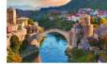
สะพานเก่า Mostar
